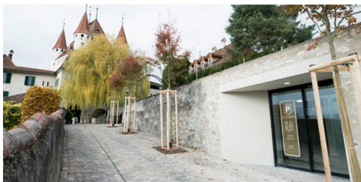
Direkt auf den Schlossberg: Das Parking bietet auch eine direkte Fussgängerverbindung zu Schloss, Schlosshotel und Stadtkirche.
