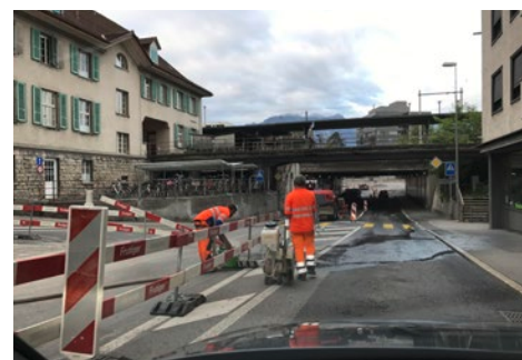
Selten mehr als zwei Baustellenarbeiter: Endlos-Baustelle Bahnhofunterführung.
